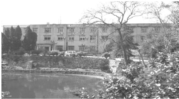
原点军乡卫生院、点军区卫生院住院门诊大楼
